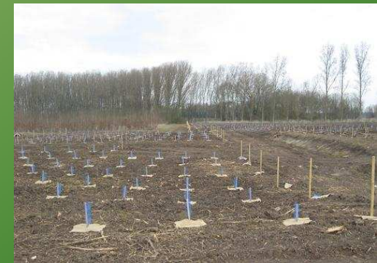
Opération de protection de captage d'eau potable.
