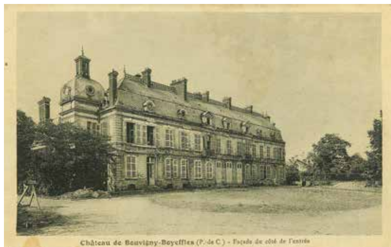
Château de Bouvigny-Boyeffles (P. de C.) - Façade du côté de l'entrée
